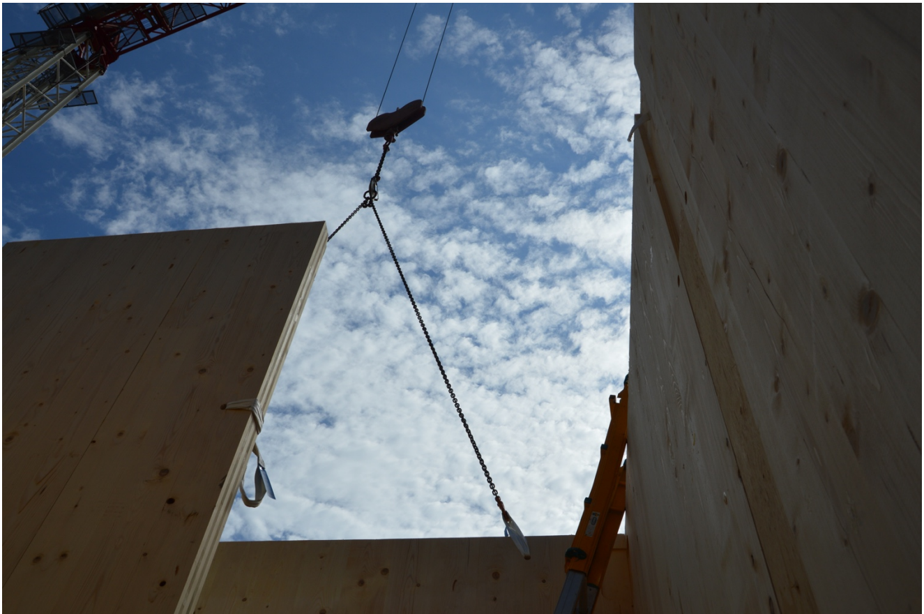
Figura 7- Sollevamento di una parete a pannelli
