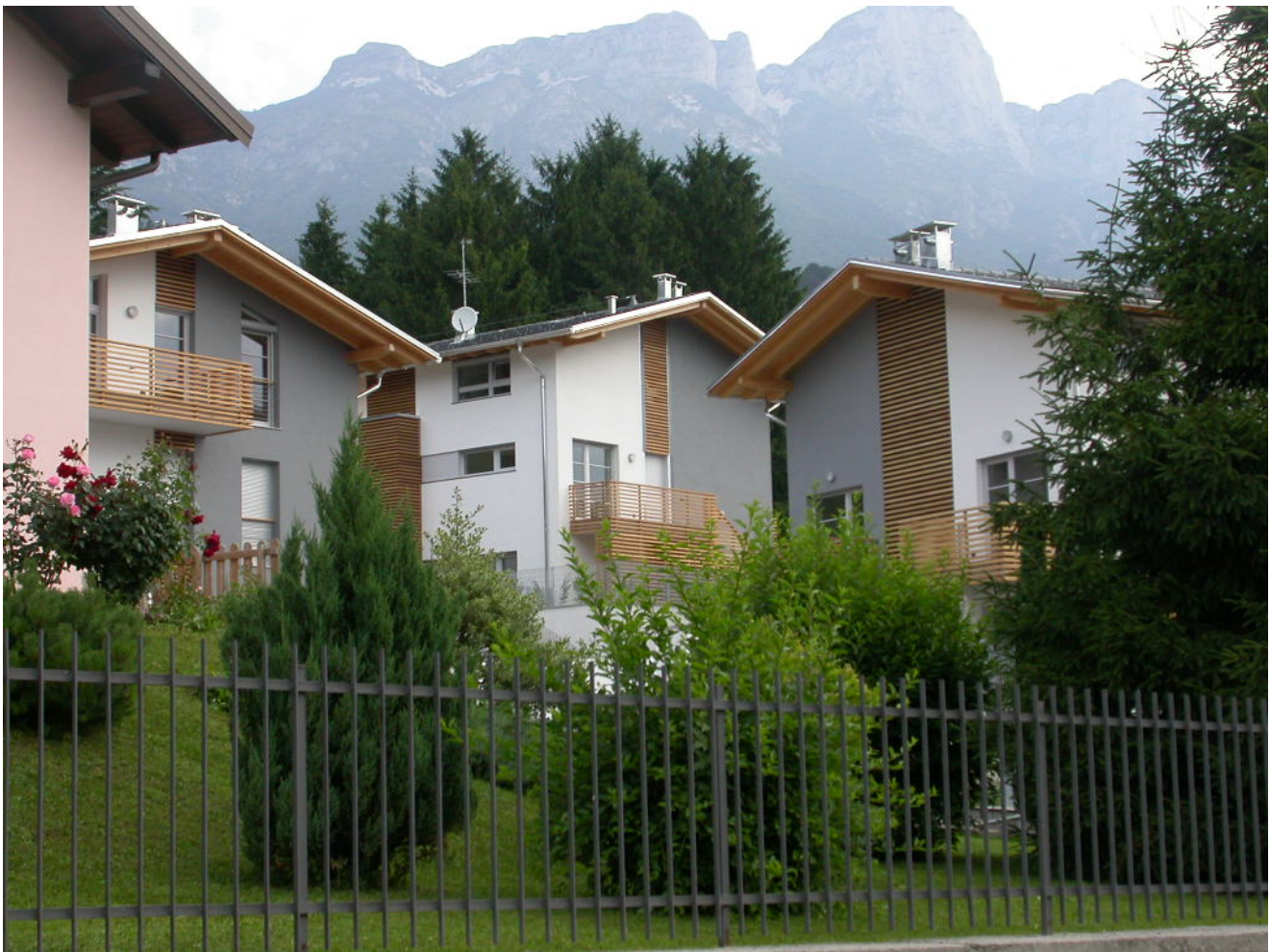
Figura 1 – Residenza Giulia (TN) – Progettazione: Gruppo cinque – architettura e ingegneria (TN)
