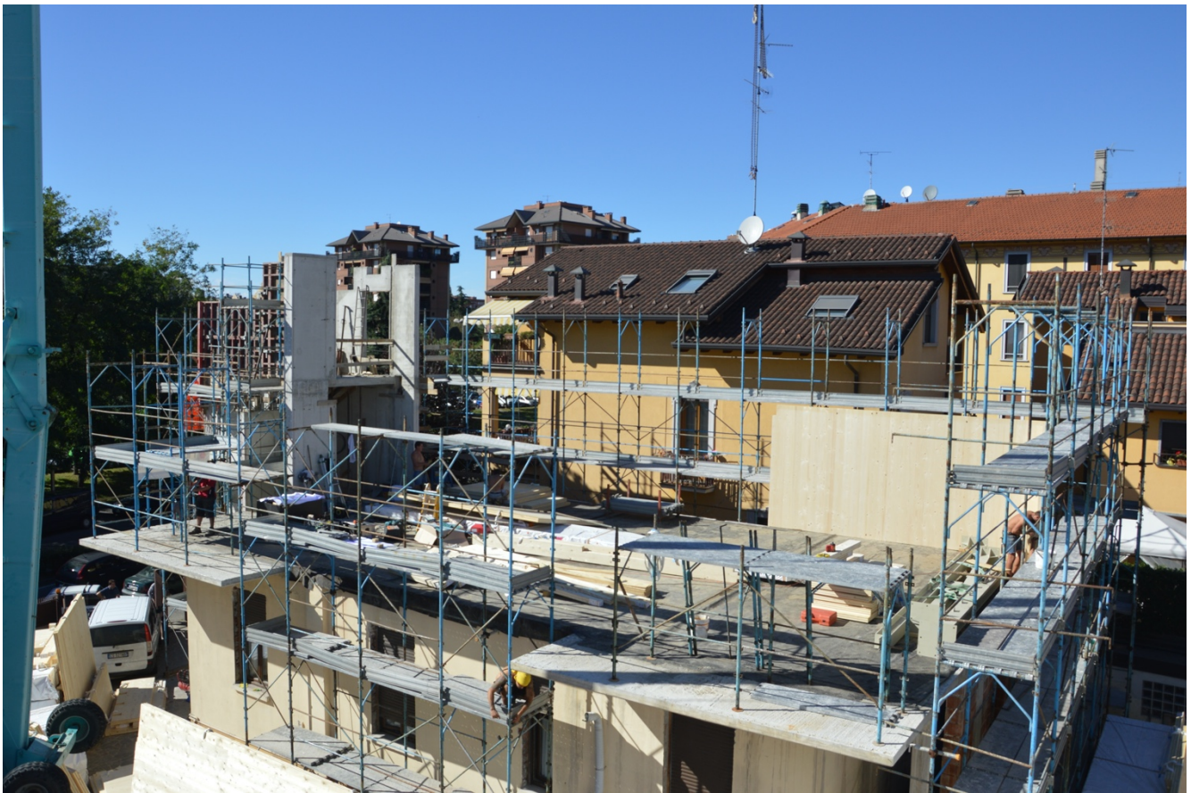
Figura 5 - Sopraelevazione di due piani in legno - Primo giorno di montaggio
