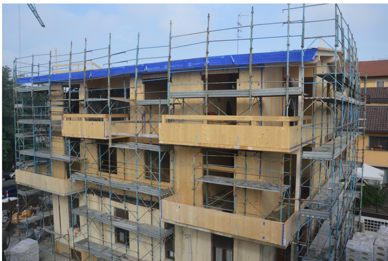
Figura 6 - Sopraelevazione di due piani dopo 9 giorni di lavoro
