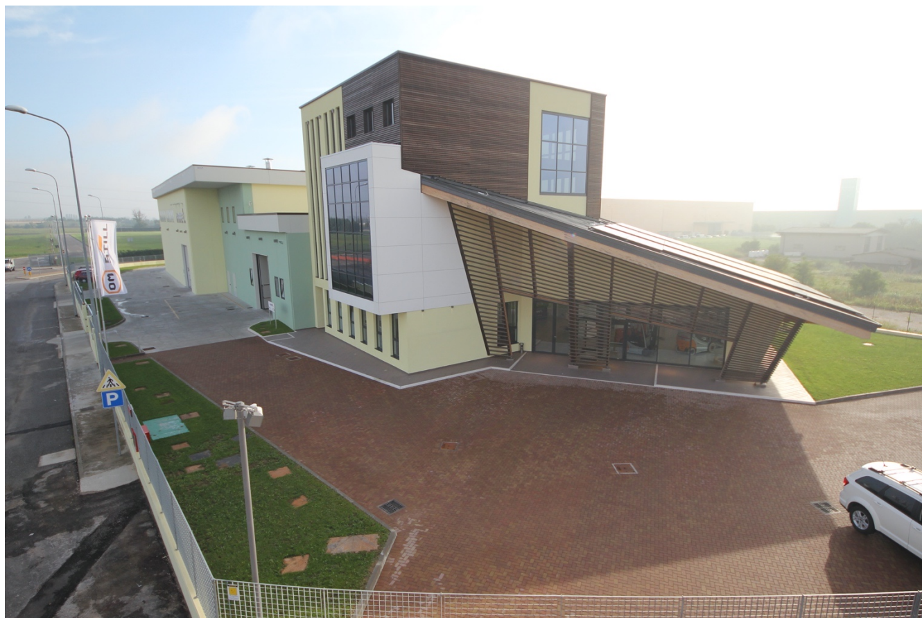
Figura 3 - Edificio direzionale a Mantova - Progettazione: Studio Edhas (MN)
