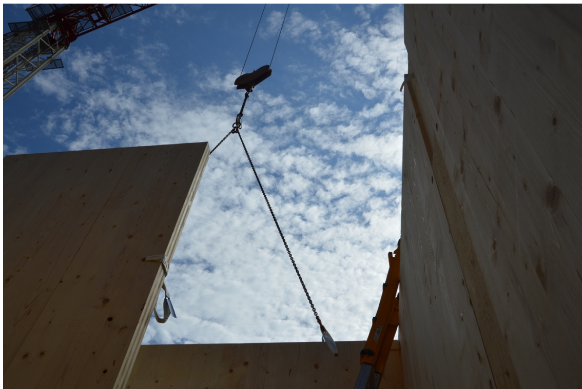
Figura 7- Sollevamento di una parete a pannelli
